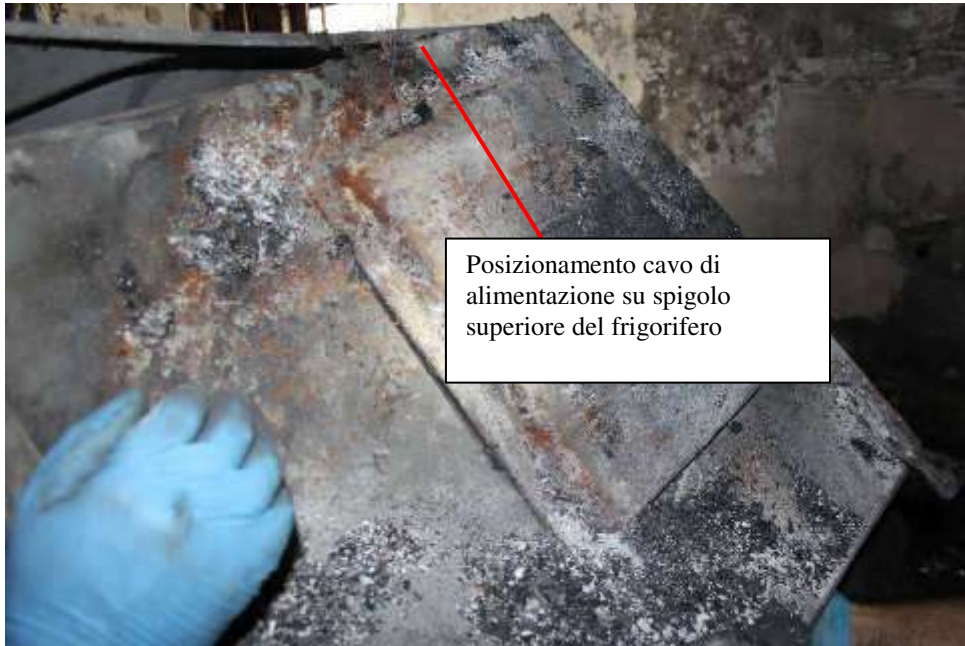
Cavo elettrico di alimentazione del frigorifero
