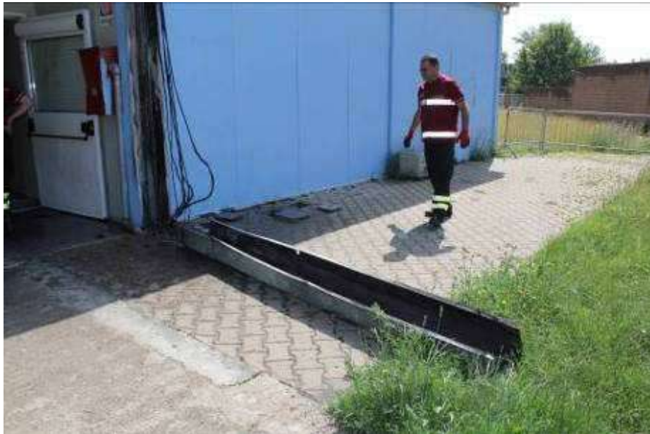
Riposizionamento della lamiera metallica
