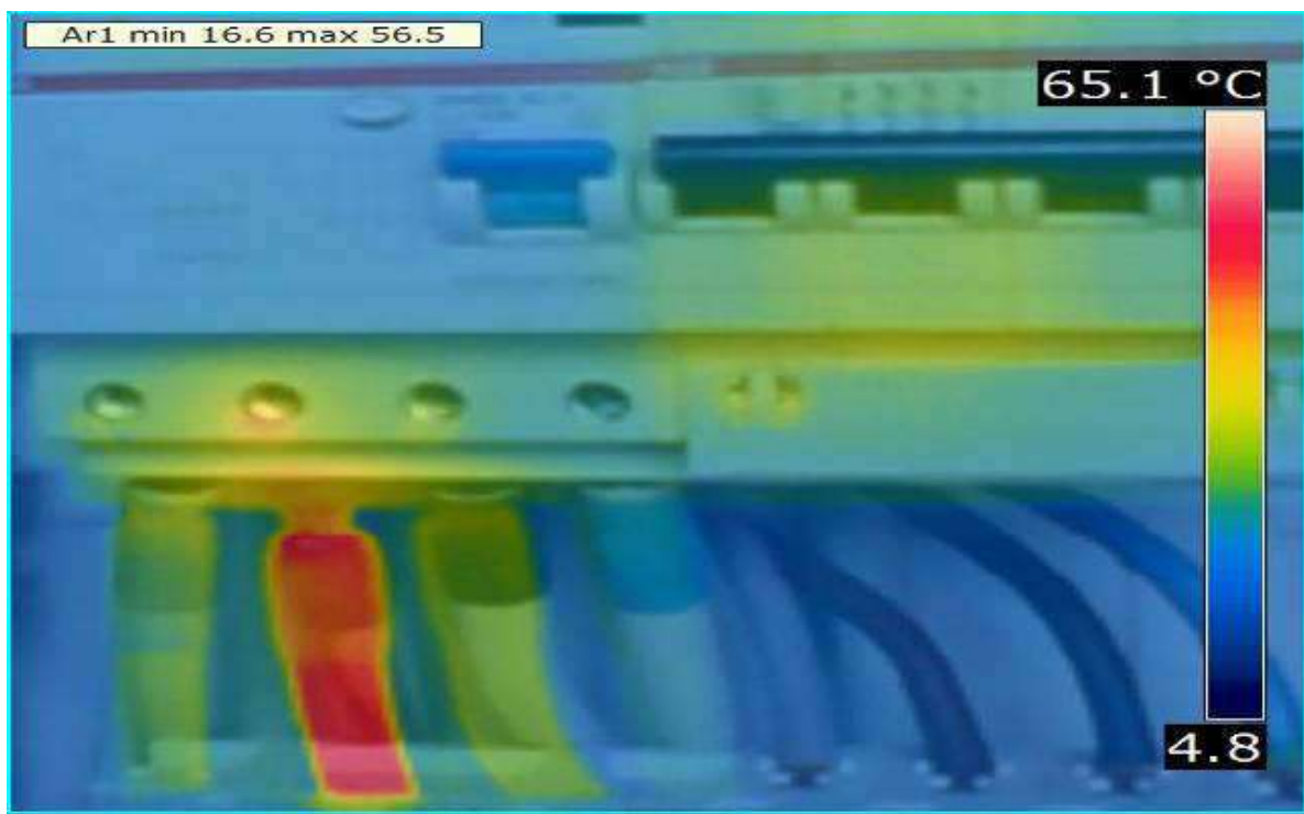
Termografia applicata ad un interruttore magnetotermico differenziale
