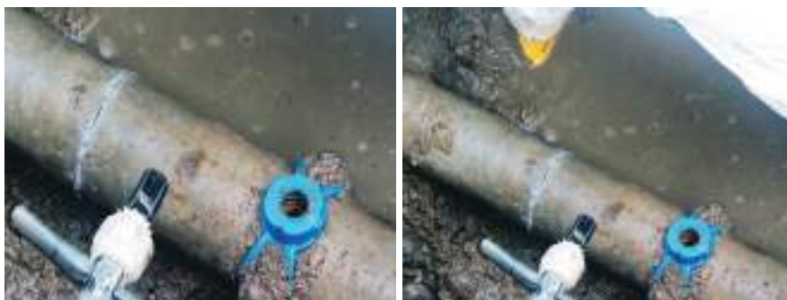
Figura 16 - Particolare del punto di derivazione.
