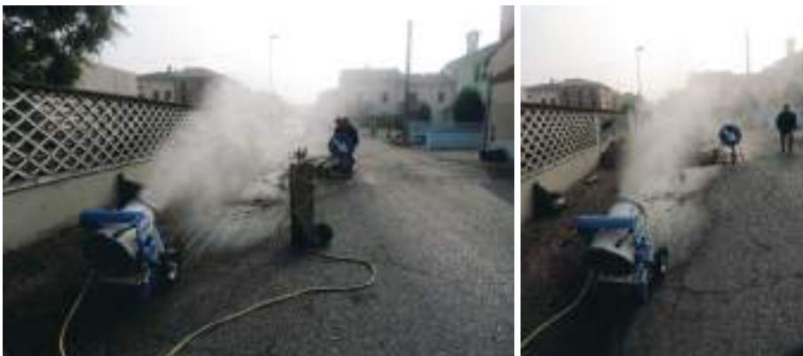
Figura 5 - Cannone nebulizzatore nell'area d'intervento.
