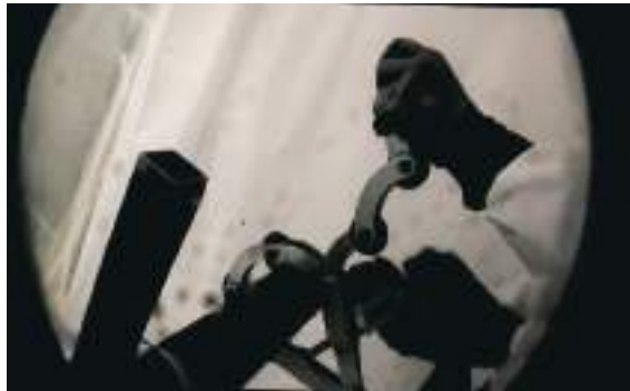
Figura 15 - Particolare di una lavorazione mediante tagliatubi manuale a catena.
