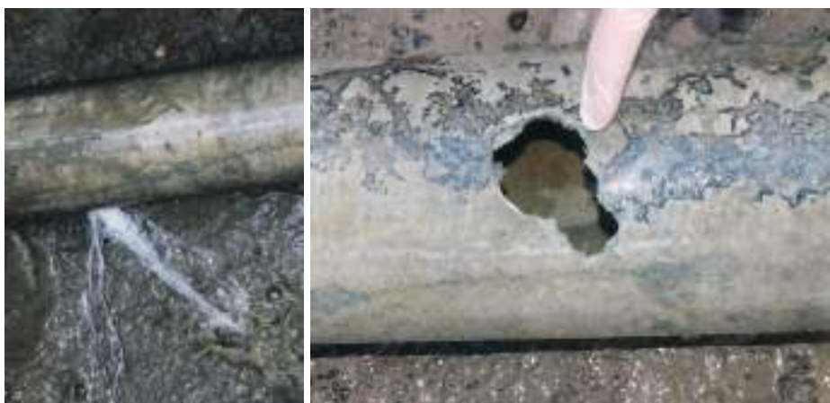
Figura 2 - Tubazione idrica in cemento amianto lesionata.
